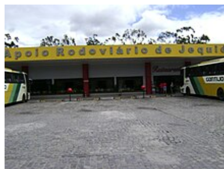
Apoio Rodoviário de Jequié.
